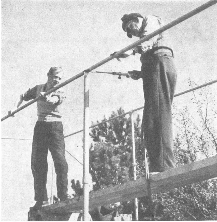
Fig. 3. Den nya helgolandfällan uppfördes med en stomme av helsvetsade stålrör. Foto: ARNE ORVELIUS. ( A new Heligoland trap with a frame of steel piping was built in 1956. )
